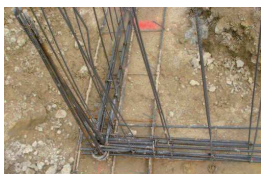
Nœud de chaînage - Continuité mécanique
