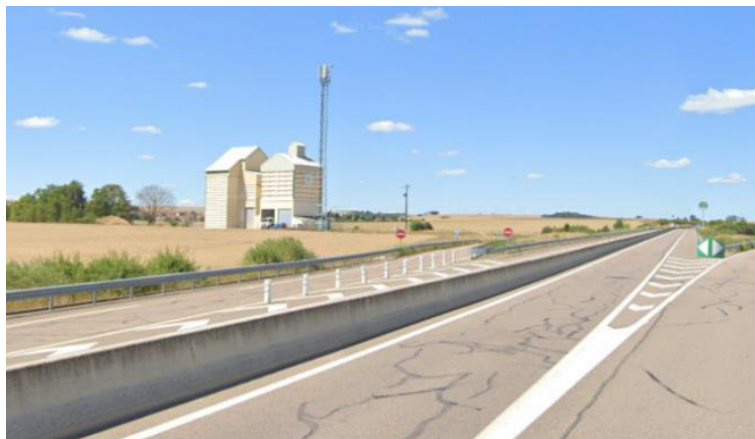
Silos et antenne marquant l'entrée sur la commune depuis la RD903 (Source photo : Streetview)
