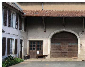
Cette façade accueille une ouverture avec un arc en anse de panier et une porte en bois caractérisant l'architecture rurale et patrimoniale de notre département. Le auvent avec une structure bois rapportée sur des corbeaux est un élément important à conserver.
