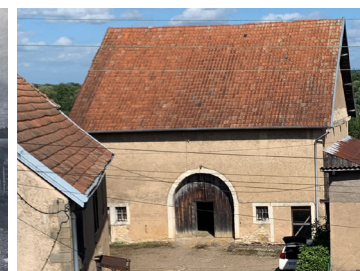
Ce bâtiment dispose de peu d'ouverture. Il a la particularité d'avoir un niveau de rez-de-chaussée surélevé par rapport au sol du terrain côté Est ; cela est une contrainte pour sa réhabilitation. Peu de modénatures sont présentes mis à part certains encadrements des ouvertures en grès ou en pierre de taille.
