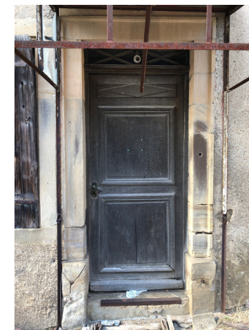
Cet ensemble, porte en bois et encadrement en pierre de taille sculpté participe à l'intérêt patrimonial de la construction.
