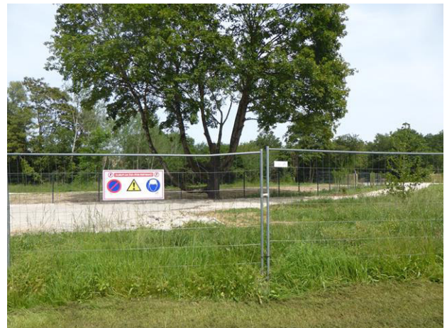
Une zone en cours d'aménagement en 2023
