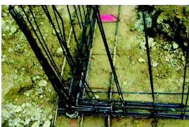
Nœud de chaînage - Continuité mécanique
