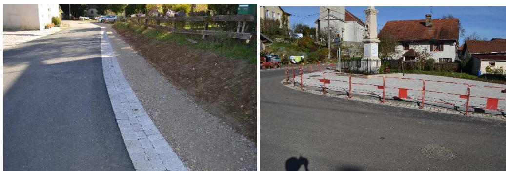
Illustration des travaux de réfection de chaussée – Réalisation DORGAT
