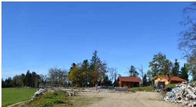
La ferme Auberge – Réalisation DORGAT – vocation résidentielle et de loisirs (l'auberge à brûlée mais elle sera reconstruite sur l'ancien site).
