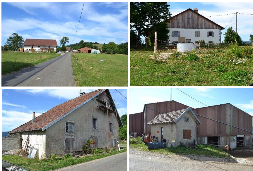
Constructions du hameau de Chauvilliers – Réalisation DORGAT
