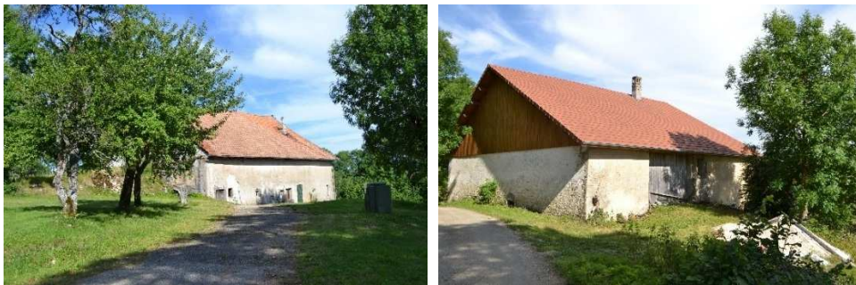
Surmont – Réalisation DORGAT
