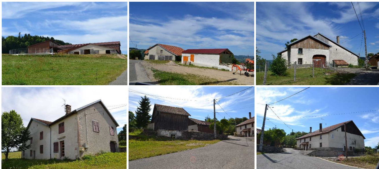
Constructions du hameau de Montnoiron – Réalisation DORGAT
