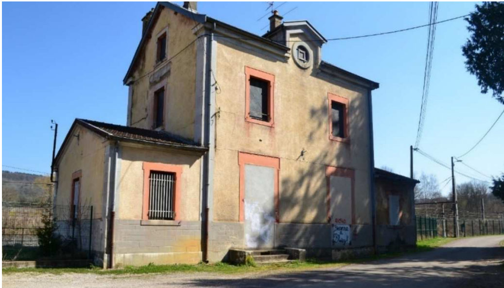
BLAISY-BAS – La Gare extérieure
