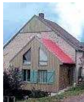
Percements en pignon
