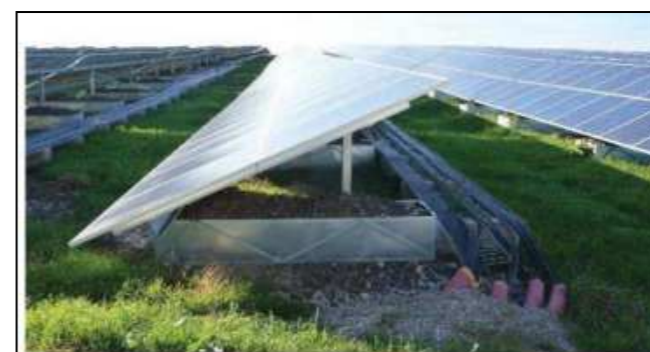
Figure 16 : Fixation par des gabions (Source : Quadran)
