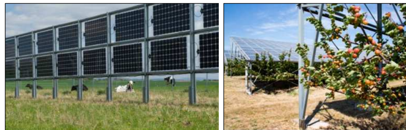
Figure 12 : Exemple de tables PV (Source : ABO Energy)
