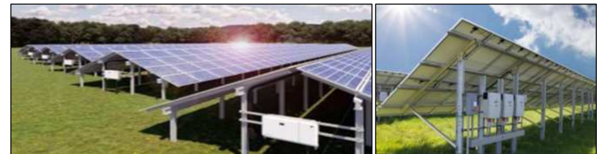
Figure 8 : Exemples d'onduleurs décentralisés répartis sur l'aire de la centrale photovoltaïque (Source ABO Energy)
