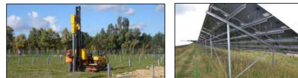
Figure 17 : Exemple de battage de pieux et fondation en pieux métalliques (Source : ABO Energy)
