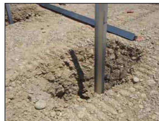
Figure 14 : Types de fondation - pieux battus (Source : Guide MEDDTL 2011 – NCA, 2015)
