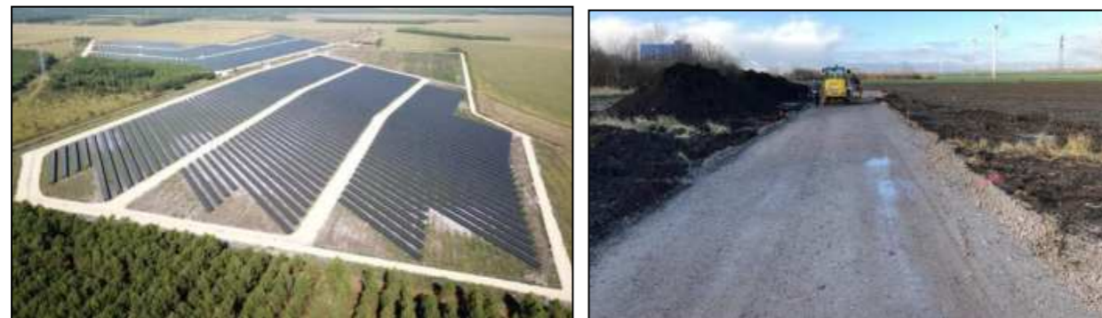
Figure 19 : Exemple de pistes pour accès à la centrale (Source : ABO Energy)
