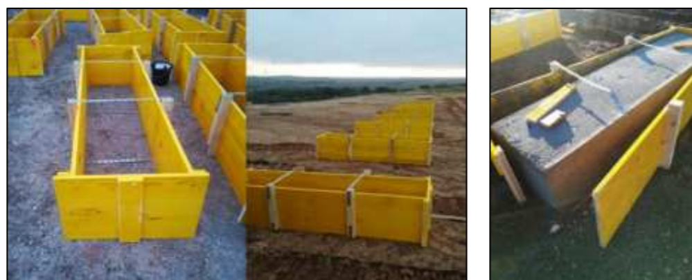
Figure 41 : Réalisation de longrines béton (Source : ABO Energy)
