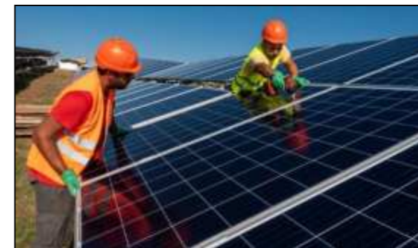
Figure 43 : Pose des modules PV sur les tables (Source : ABO Energy)
