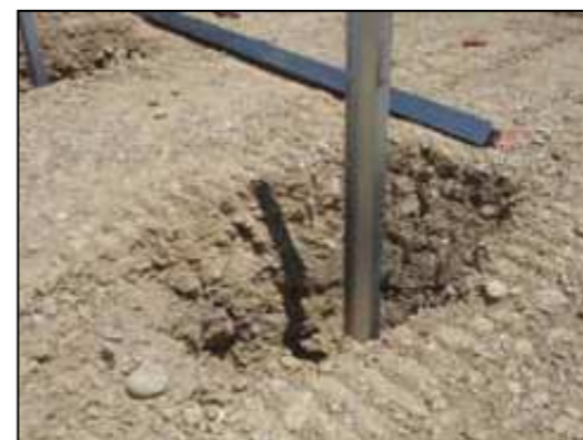
Figure 31 : Types de fondation - pieux battus (Source : Guide MEDDTL 2011 – NCA, 2015)
