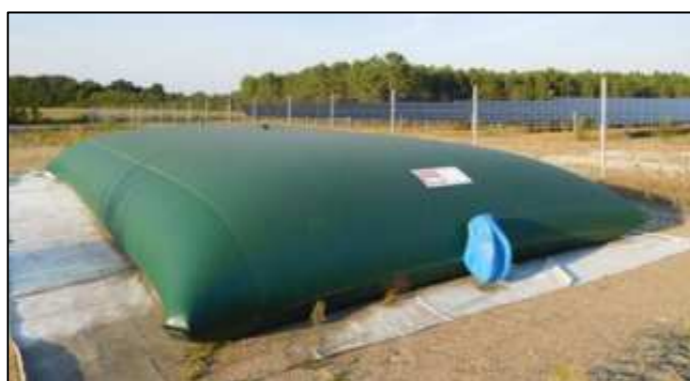
Figure 37 : Exemple de Point d'eau Incendie pour une centrale photovoltaïque (Source : ABO Energy)
