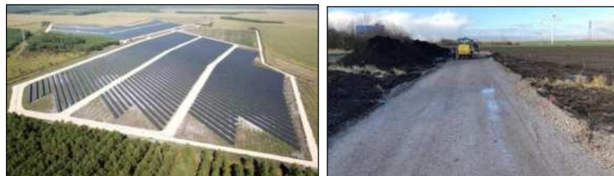
Figure 36 : Exemple de pistes pour accès à la centrale (Source : ABO Energy)
