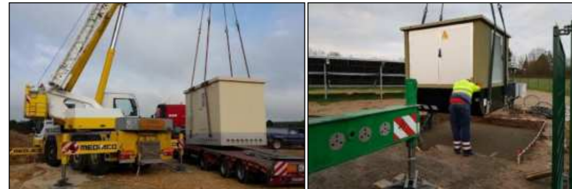
Figure 44 : Grutage des postes électriques sur site (Source : ABO Energy)
