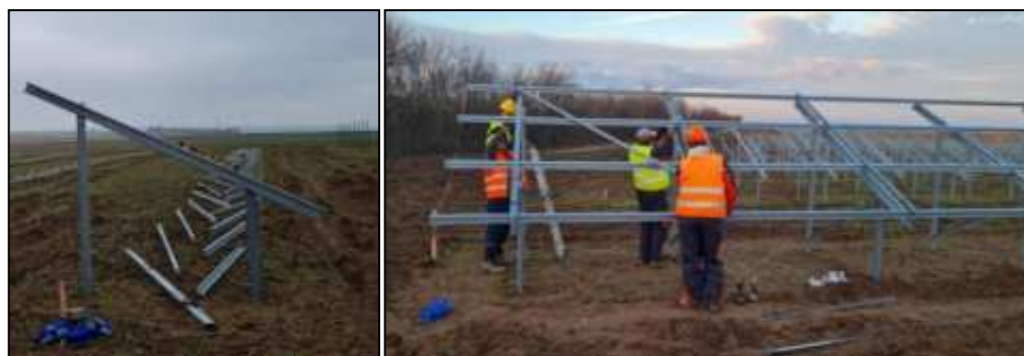
Figure 42 : Assemblage des tables photovoltaïques (Source : ABO Energy)
