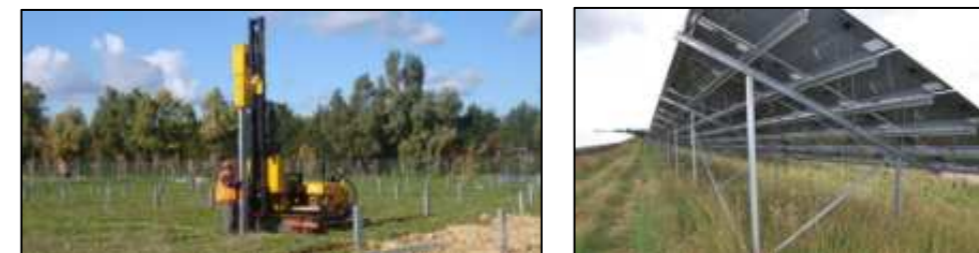
Figure 34 : Exemple de battage de pieux et fondation en pieux métalliques (Source : ABO Energy)
