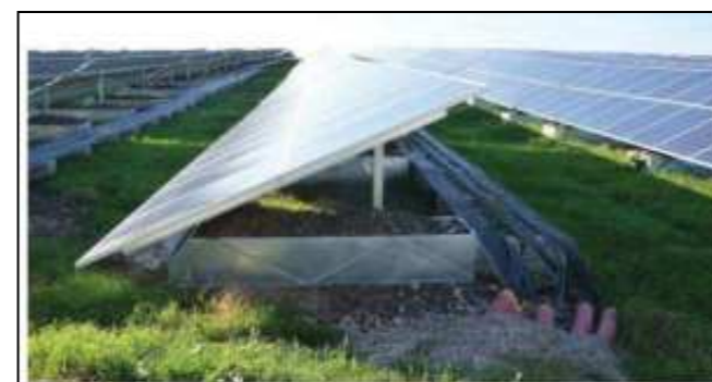
Figure 33 : Fixation par des gabions (Source : Quadran)
