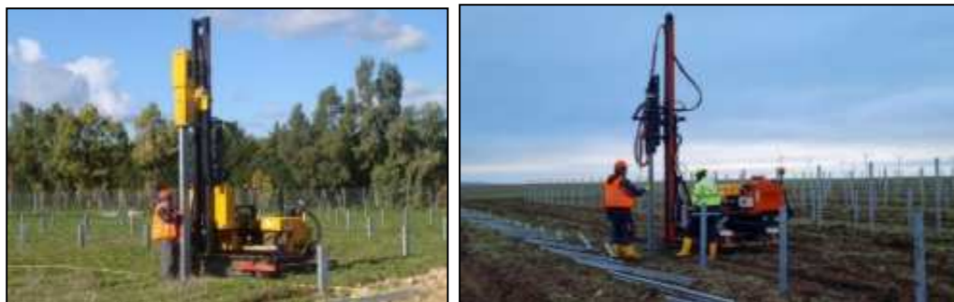
Figure 40 : Battage de pieux métalliques (Source : ABO Energy)
