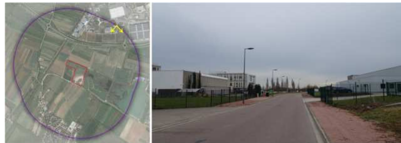
Figure 292 : Photographie de la zone industrielle présente au nord de l'AEI (Crédit photo : NCA Environnement)
