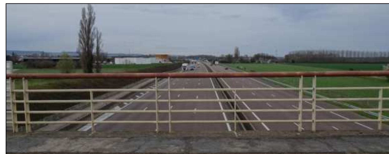
Figure 211 : Photographie du passage de l'autoroute A6, à l'est de l'aire d'étude éloignée (Crédit photo : NCA Environnement)
