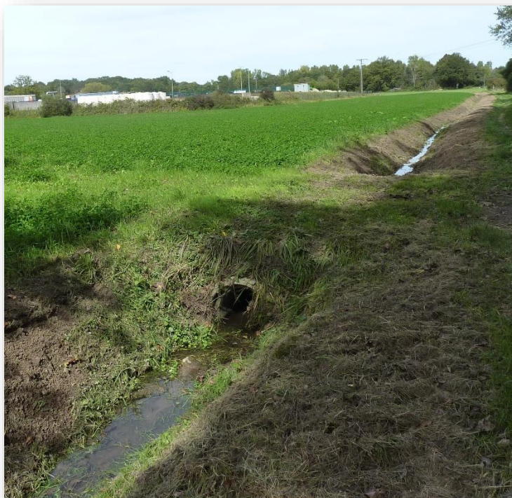
Fossé de drainage au lieu-dit « le Breuil »
