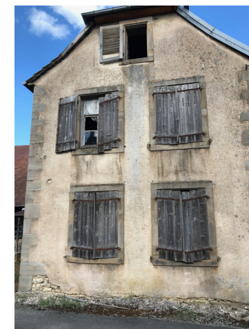
La symétrie des ouvertures en façade est caractéristique d'une construction patrimoniale. Les encadrements des ouvertures et les chaînages d'angle en grès sont des modénatures intéressantes à mettre en valeur.
