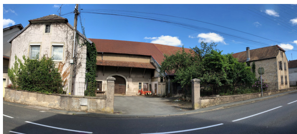
Deux bâtiments ayant pignon sur rue et un bâtiment en retrait formant un espace ouvert créent une composition urbaine à conserver.
