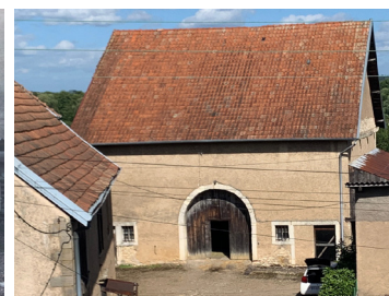
Ce bâtiment dispose de peu d'ouverture. Il a la particularité d'avoir un niveau de rez-de-chaussée surélevé par rapport au sol du terrain côté Est ; cela est une contrainte pour sa réhabilitation. Peu de modénatures sont présentes mis à part certains encadrements des ouvertures en grès ou en pierre de taille.
