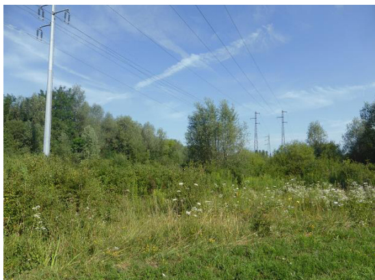
Friches herbacées et arbustives sous les lignes électriques
