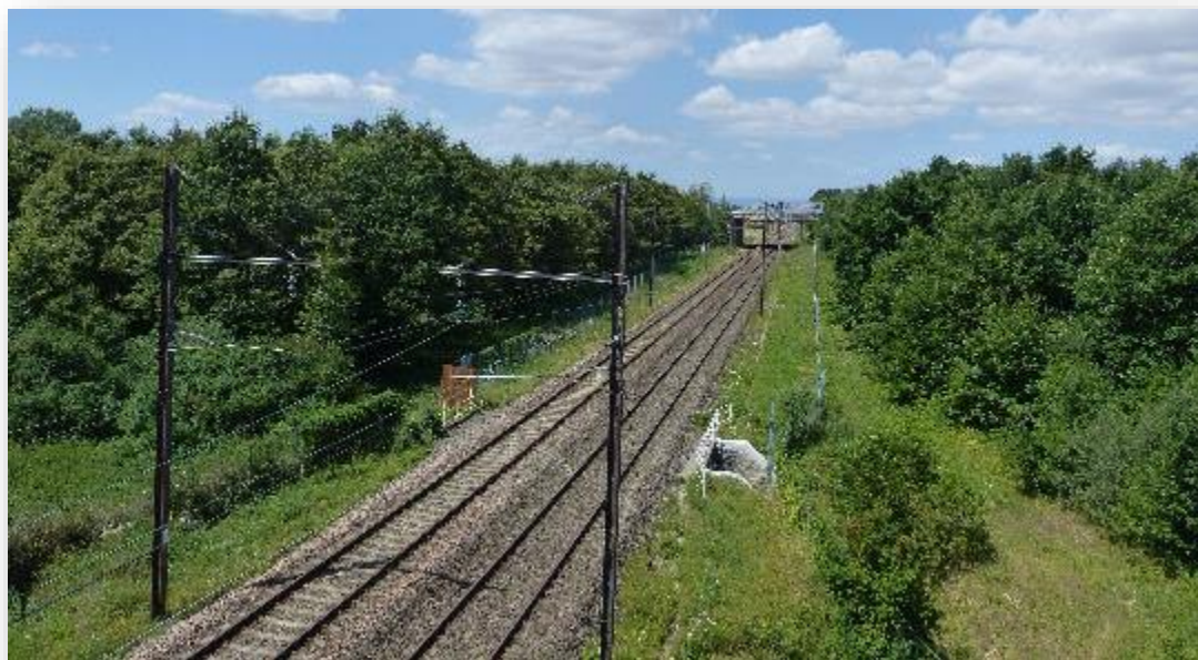
Vue sur la ligne LGV au lieu-dit « Petit Bois le Duc »
