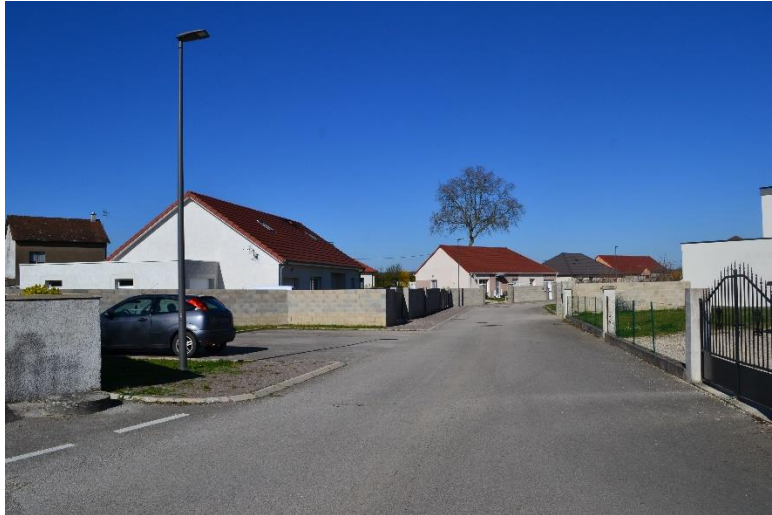
Ensemble bâti récent dont les clôtures n'ont pas été enduites – Source : DORGAT
