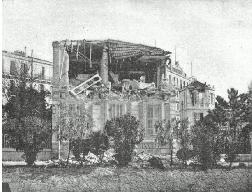
Illustration 10: Destruction de bâtiments à Menton (06) suite au séisme de 1887 et à la liquéfaction des sols (Source : Les Tremblements de Terre - FA Fouqué)
