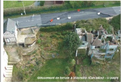
Conséquence d'un glissement de terrain (Calvados) – (Source : DIREN)
