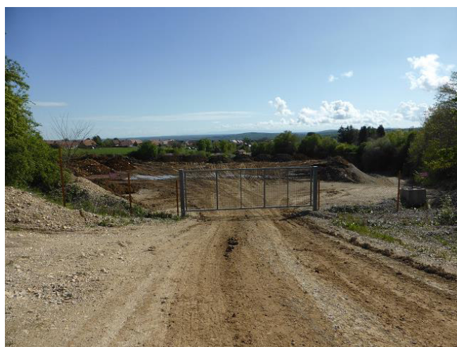
Zone de dépôt d'inertes
