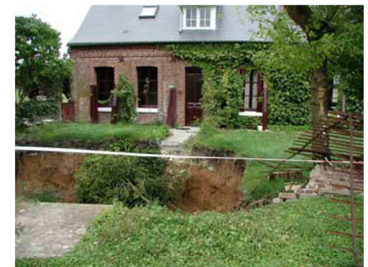
Conséquence d'un affaissement (Somme) – (Source : BRGM)
