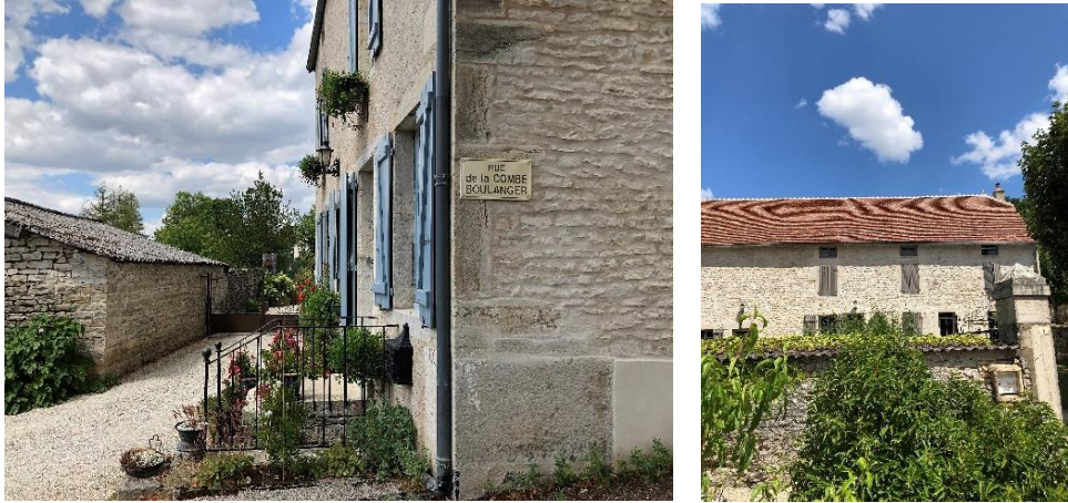
Caractéristiques architecturales du bâti ancien du bourg de Courtivron – Source : DORGAT
