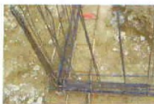
Nœud de chaînage - Continuité mécanique
