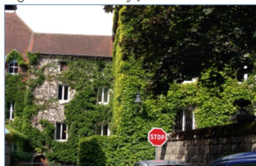
Végétalisation couvrante en façade
