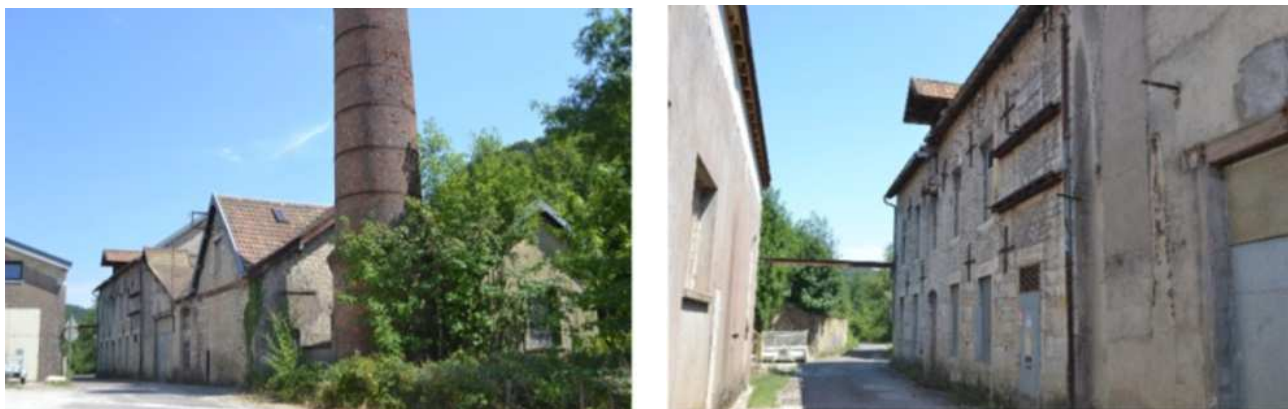
Zoom sur les bâtiments du moulin des tissages l'abandon
