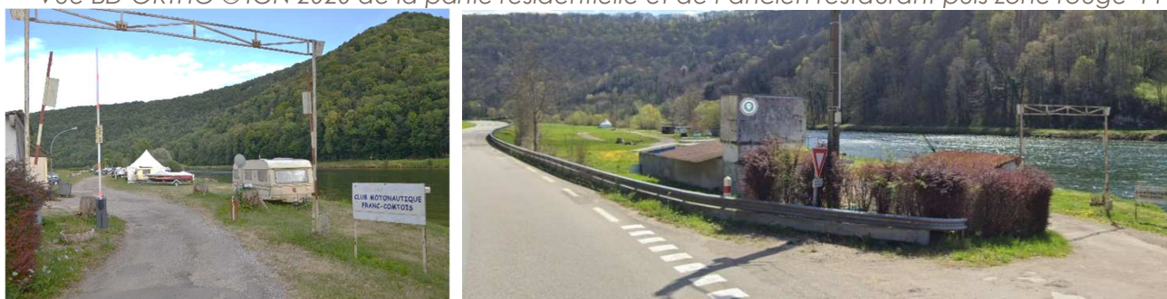
Installations de la base nautique de Lonot et du Club Nautique Franc-Comtois en 2019 puis en 2021
