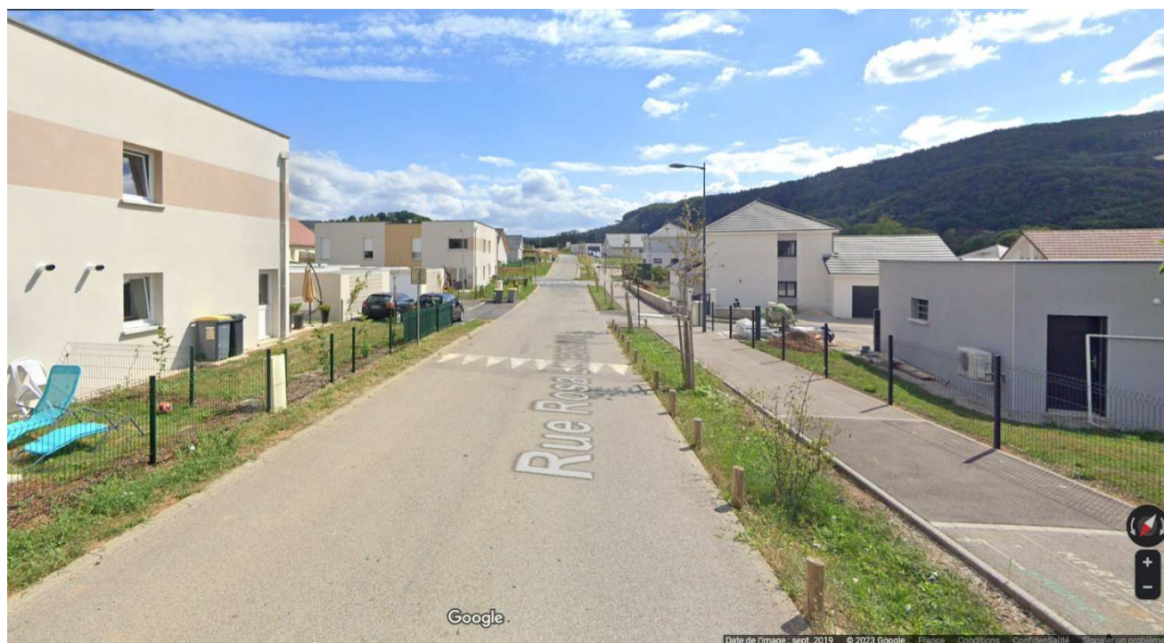
ZAC de Champvans – Partie Habitat depuis la rue Rosa Luxembourg- Source : Google Street view
