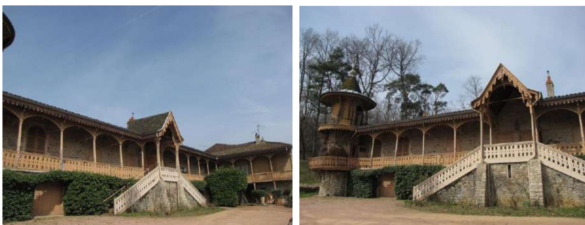
Vues sur la façade sud-est du bâtiment
