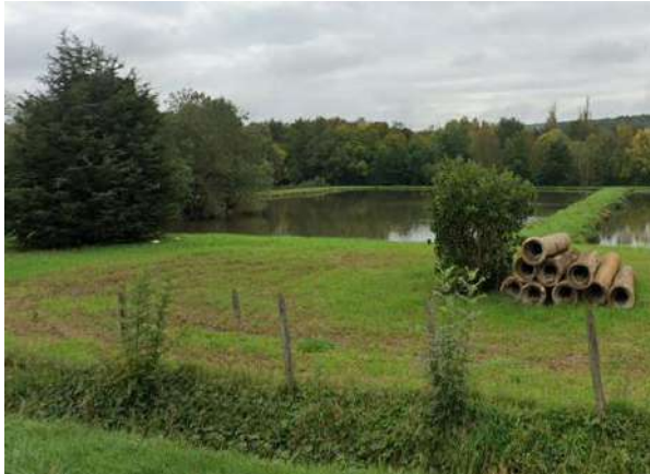
Les réservoirs de la station d'épuration ne possèdent pas de végétation au sein et autour du bassin.
