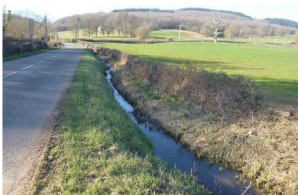
Le cours d'eau de la Mouge avant les travaux.
